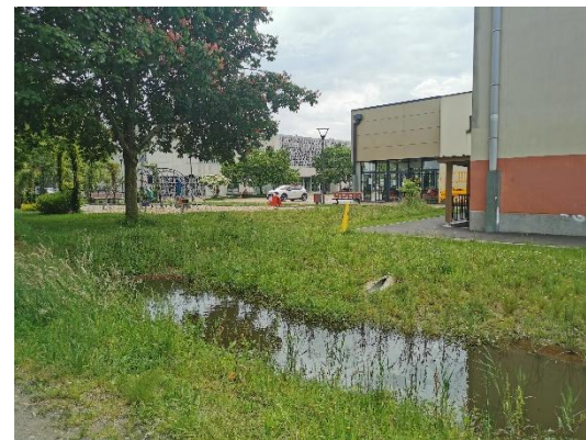
Jardin de pluie permettant de stocker et d'infiltrer les eaux pluviales du cinéma de Fougères
