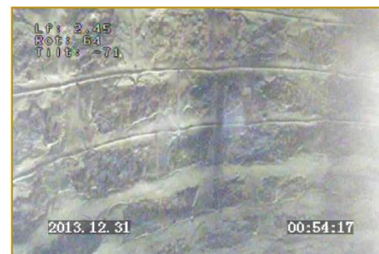
Photos d'investigation terrain menées par LogHydro pour le compte du SMG35 dans le cadre de l'étude « captages souterrains abandonnés – dpt 35
