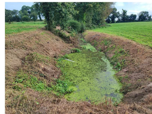
Ruisseau des Coursières avant travaux
