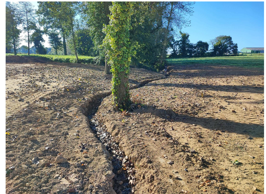
Ruisseau des Coursières après travaux. Les dimensions originelles du cours d'eau sont retrouvées. Actuellement à sec, l'eau reviendra dès les premières pluies d'automne.
