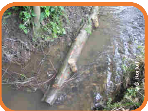
Apparition de graviers et cailloux intéressants pour la vie piscicole
