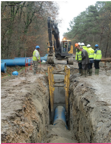
La reconstruction de l'aqueduc est en cours en forêt de Rennes afin d'économiser 300 000 à 1 000 000 de m 3 par an
