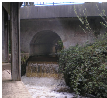
© Syndicat Loisance Minette Lavoir de St Etienne avant travaux
