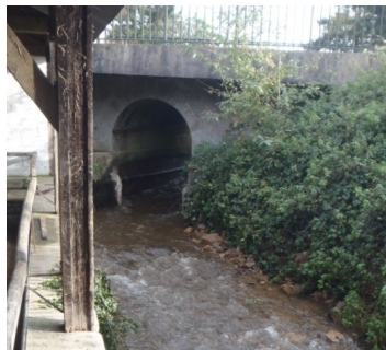
© Syndicat Loisance Minette Lavoir de St Etienne après travaux
