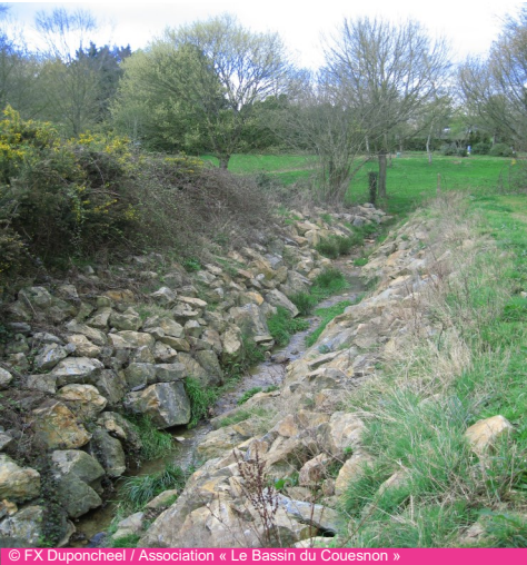
Cours d'eau rectifié et canalisé par des enrochements
