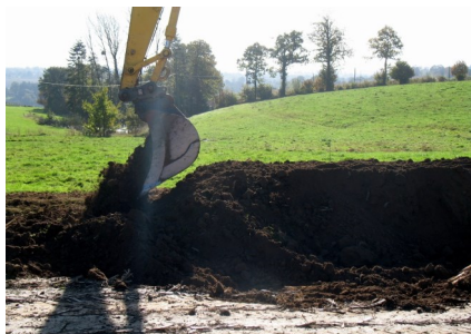
© Muriel Julita / Syndicat intercommunal du Haut Couesnon Façonnage de talus à la pelle mécanique
