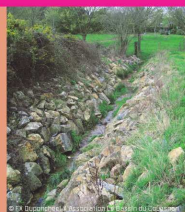
Cours d'eau rectifié
